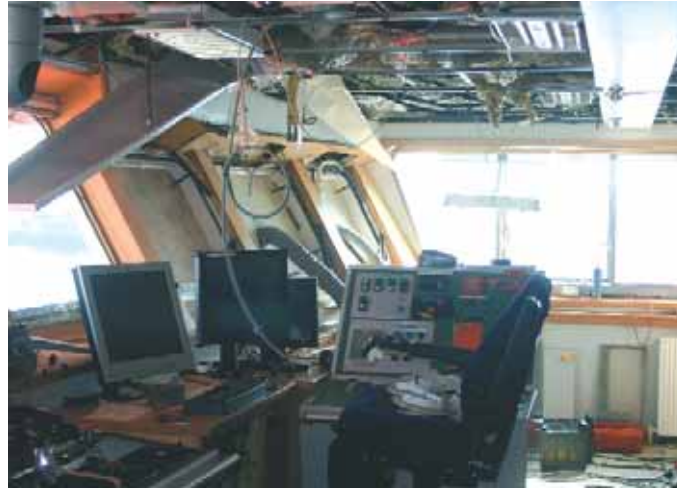
Der ventede et større oprydningsarbejde og rekonstruktion af de elektriske installationer, da Sarfaq Ittuk kom hjem til Ålborg.
