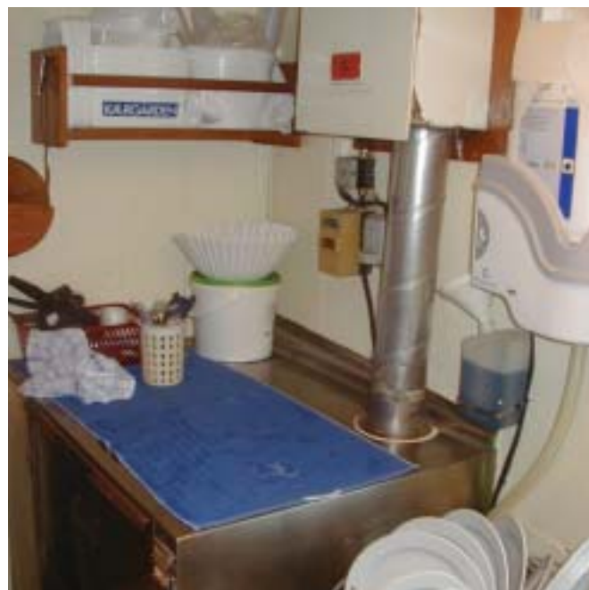
Eksempel 6: Opvaskemaskine i mindre kabys. Opvaskemaskinen er forsynet med udsugning samt automatisk dosering af vaskemiddel.
