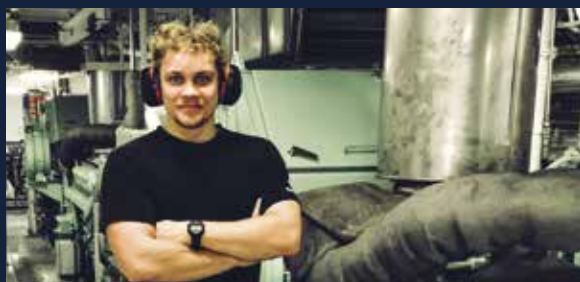
Maskinrummets usynlige påvirkning 04
