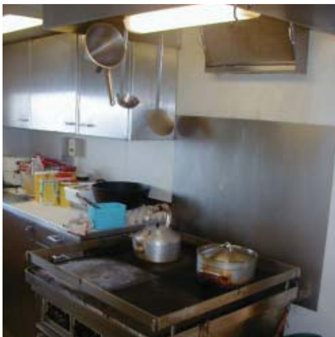
Eksempel 5: Kabys i mindre lastskib. Ovn er en del af komfuret. Emhætten sikrer, at stegeog og damp fjernes fra kabysen.
