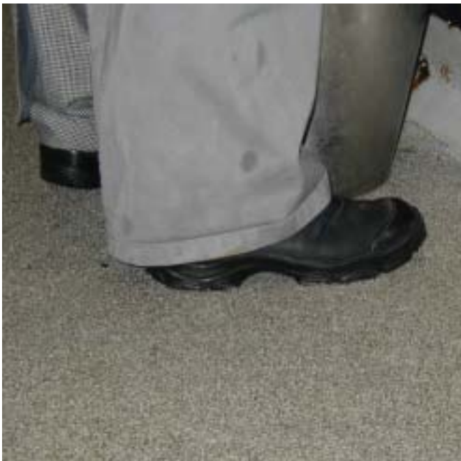
Eksempel 1: Godt fodtøj og god dørkelbelægning. Dørken er en støbt epoxybelægning iblandet kvarts. Nedsætter risikoen for faldulykker.
